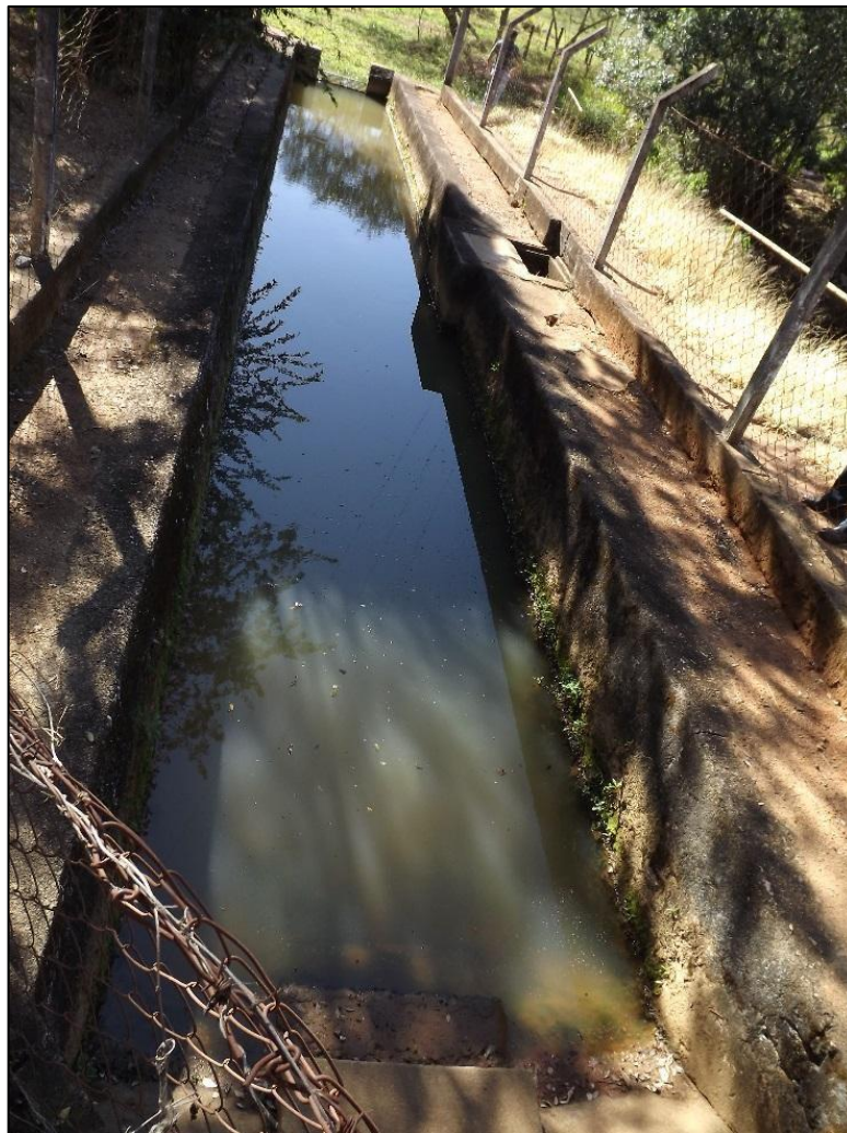
Figura 18 - Caixa de areia após a tomada de água
