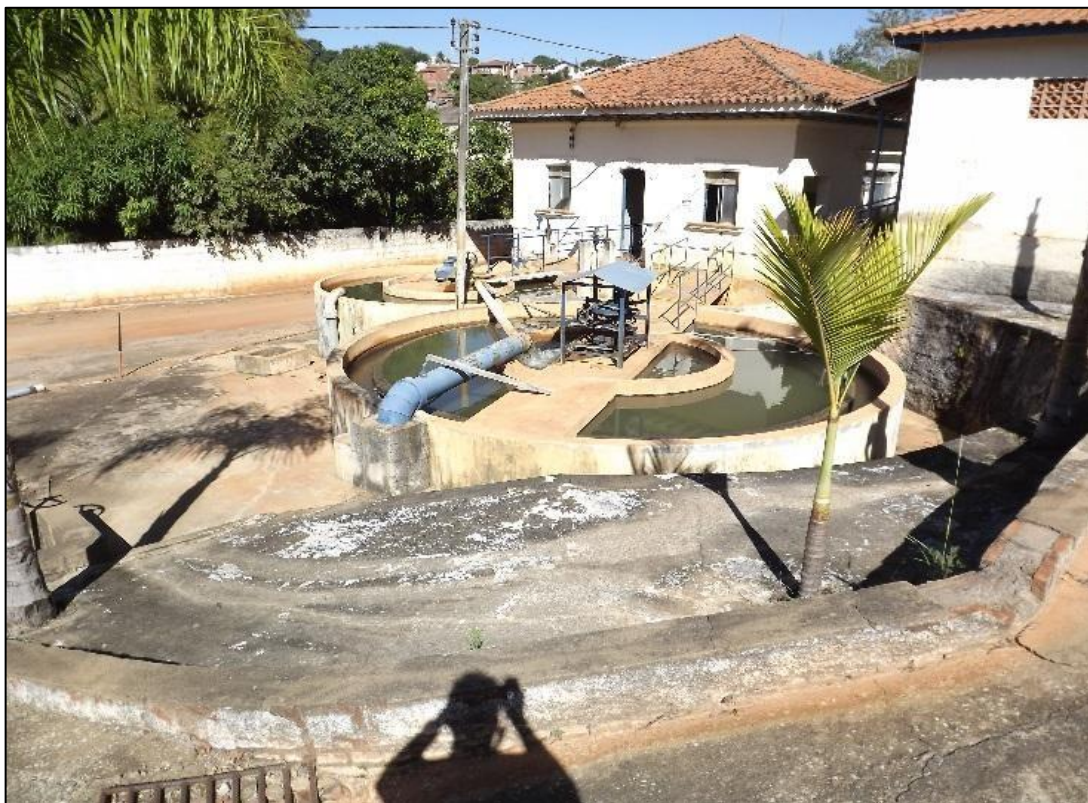
Figura 20 - Vista geral da ETA
