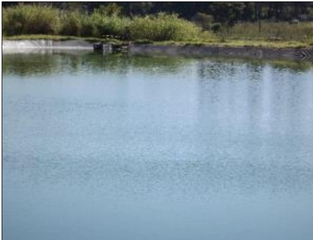
Figura 71 - Vista Geral da lagoa facultativa
