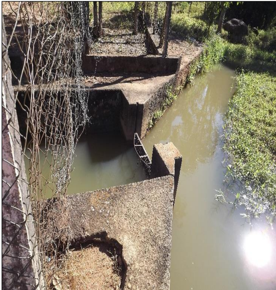
Figura 17 - Detalhe da tomada de água para abastecimento (à esq.) e vegetação no lago da barragem (à dir.)
