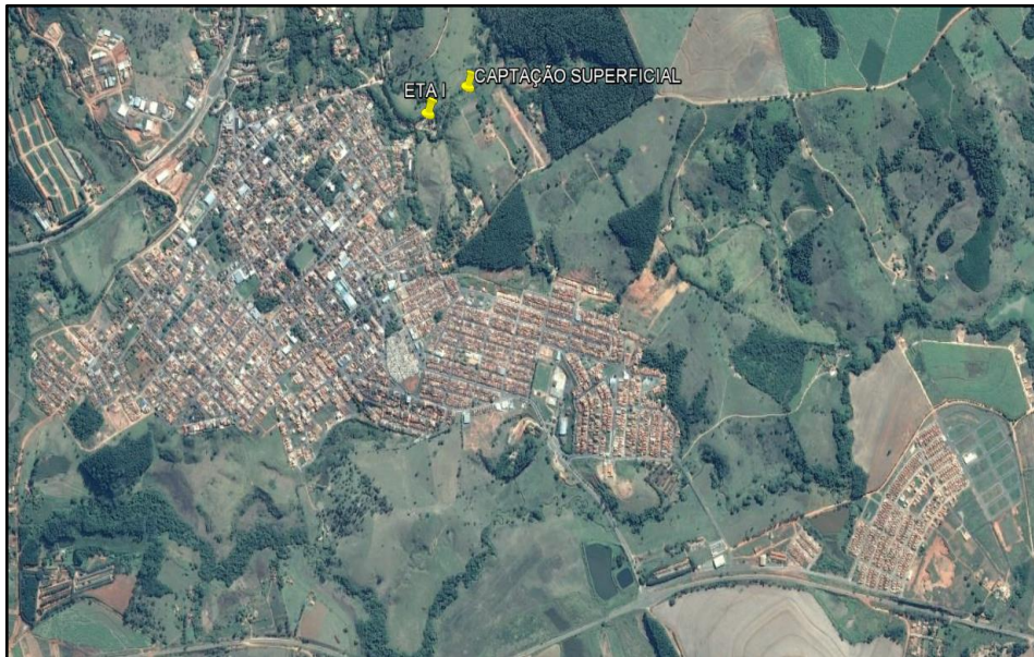
Figura 13 - Localização da Captação Superficial e da ETA
