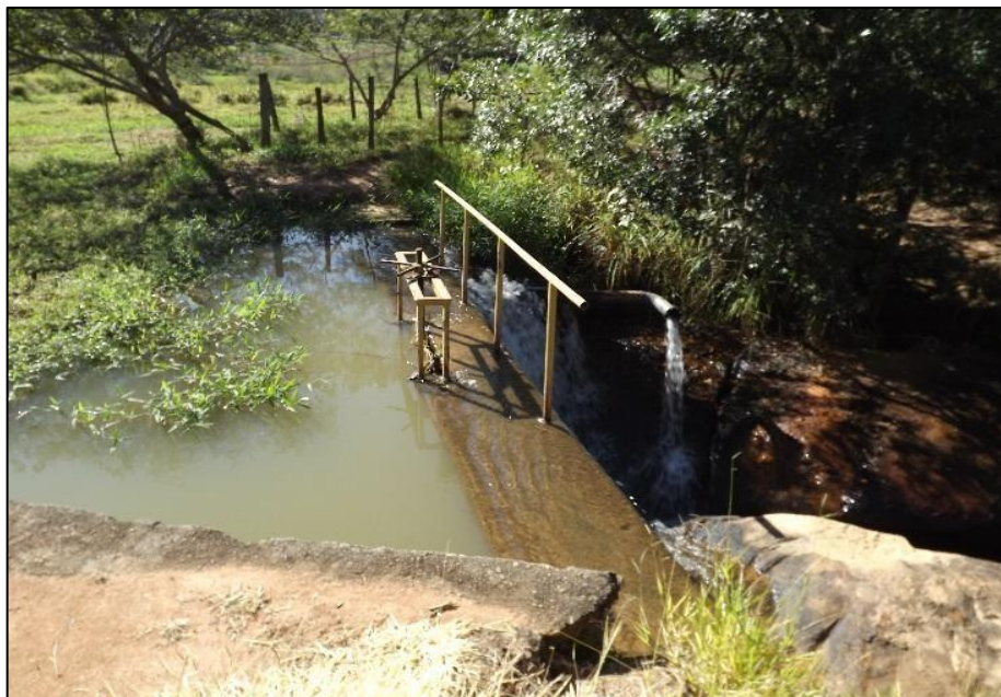
Figura 15 - Barragem de nível no Ribeirão Soledade - Captação Superficial
