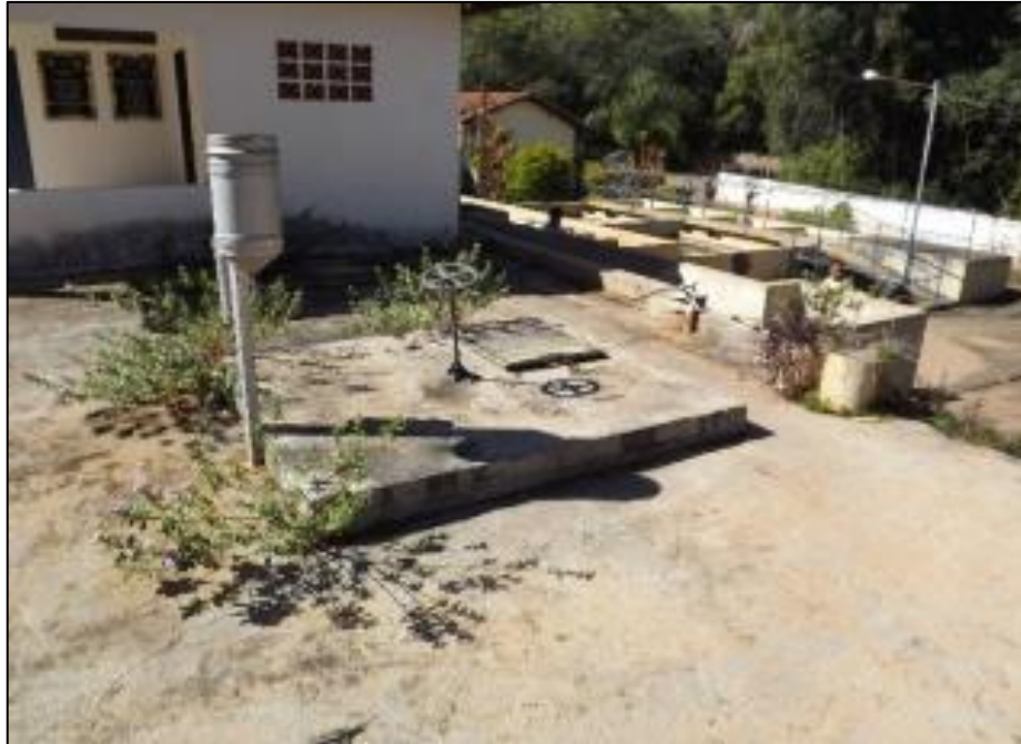
Figura 29 - Vista geral da ETA Nova (ao fundo) e do registro de manobra para envio da água bruta para ETA
