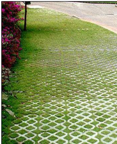
Figura 121 - Exemplo de aplicação de pavimento poroso (Concregrama)
