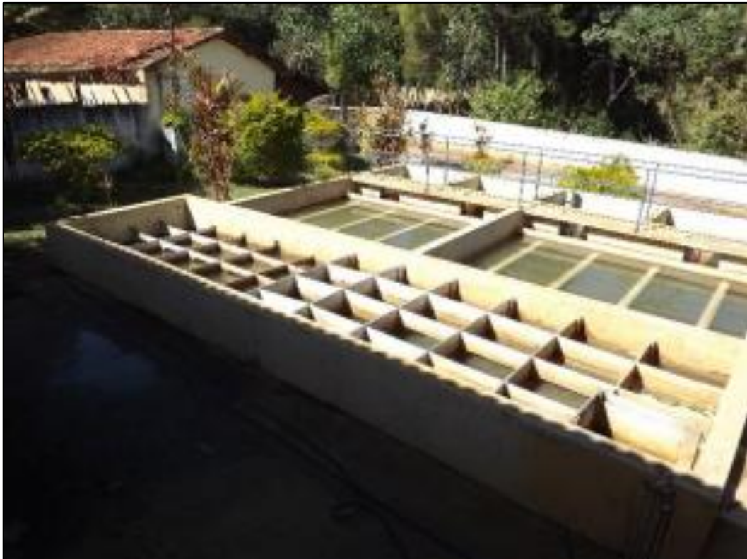
Figura 31 - Vista Geral do floculador (frente) e decantador (fundo)
