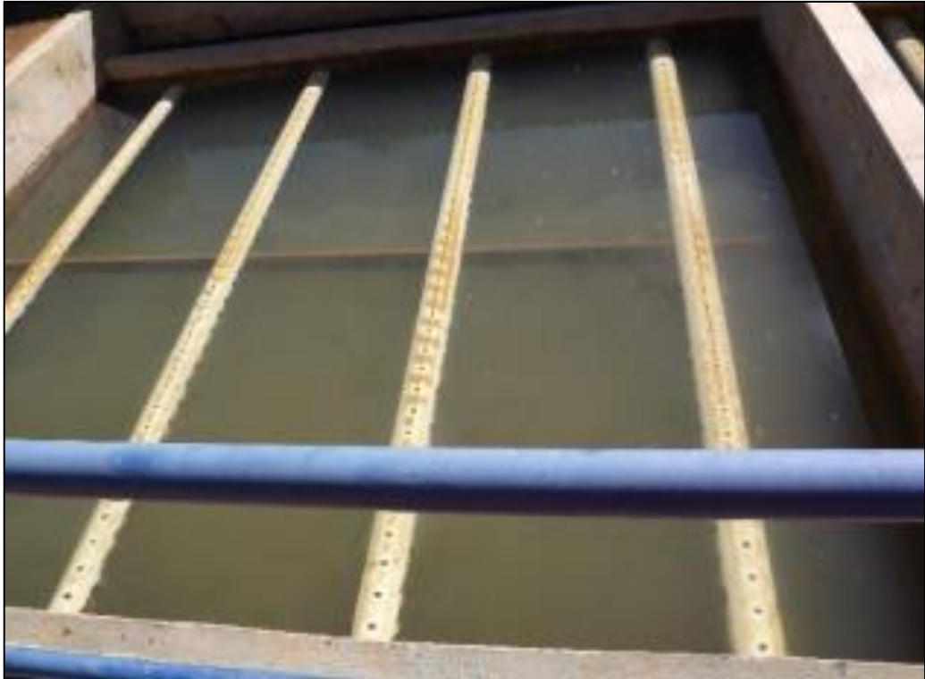
Figura 33 - Detalhe de um dos decantadores de alta taxa
