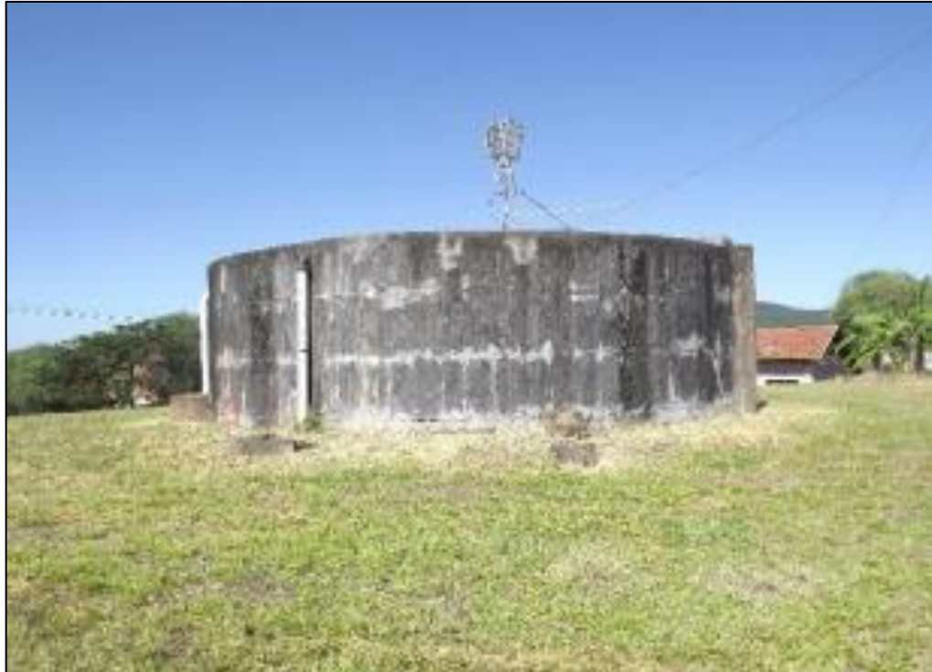
Figura 47 - Vista geral do RAP Urbano Brochi
