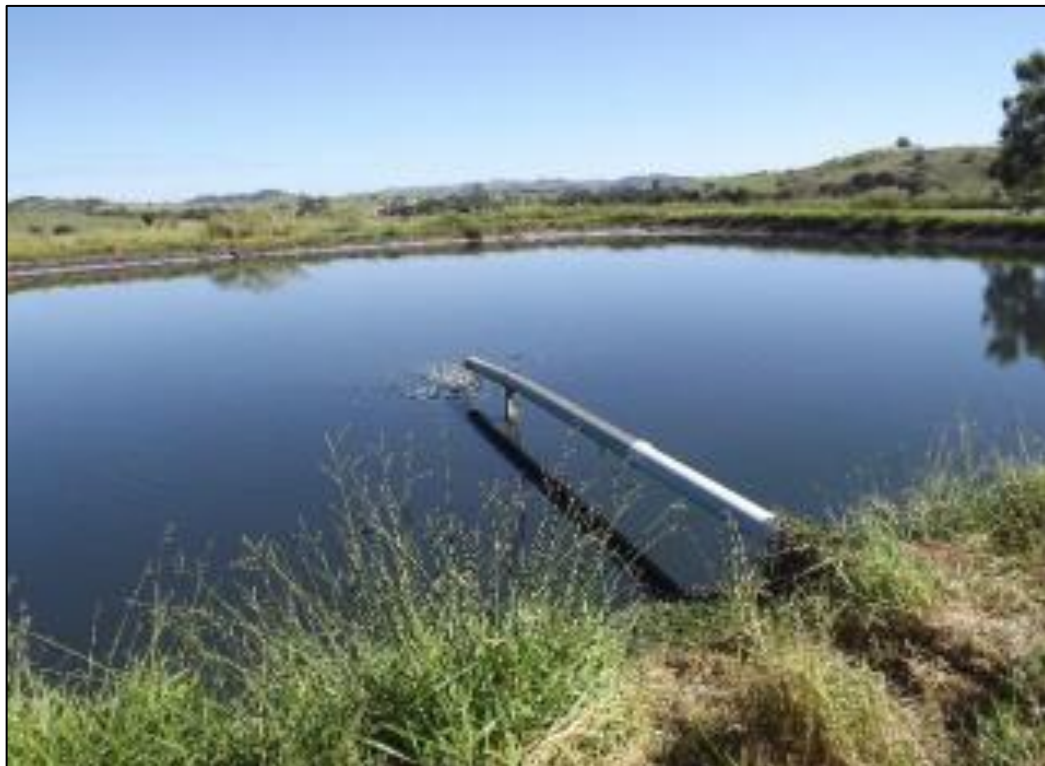
Figura 69 - Vista geral da lagoa anaeróbia
