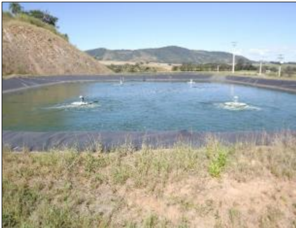
Figura 74 - Vista Geral da Lagoa aerada, com 4 aeradores
