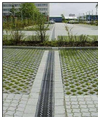
Figura 122 - Aplicação de trincheira de infiltração em passeios
