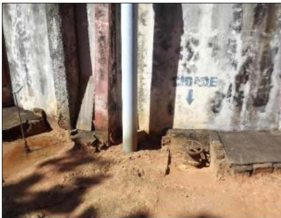
Figura 40 - Detalhe de saída do RAP Central para a região central, com registro
