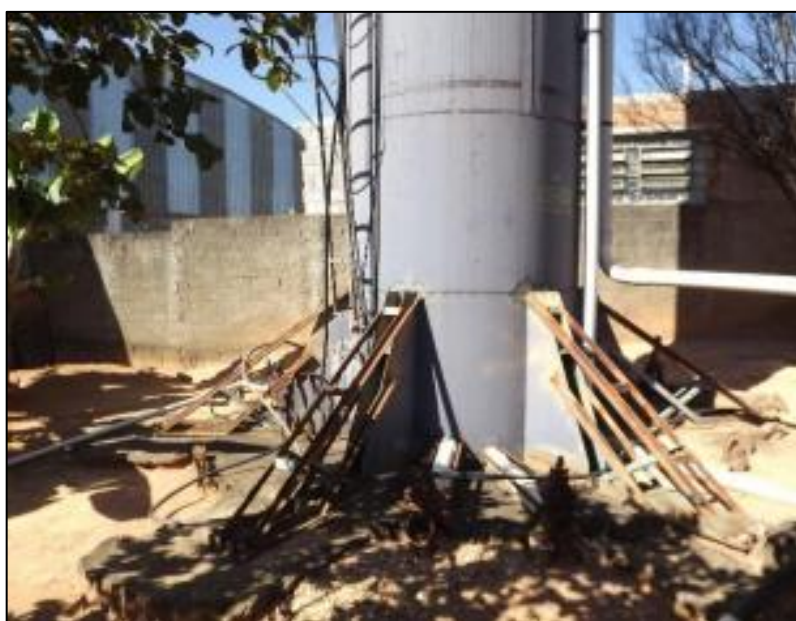
Figura 46 - Detalhe do escoramento do REL Central
