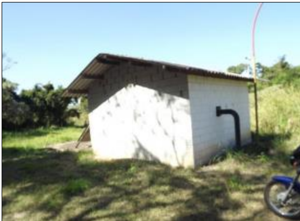
Figura 66 - Vista Geral da casa de bombas da EEE Soledade
