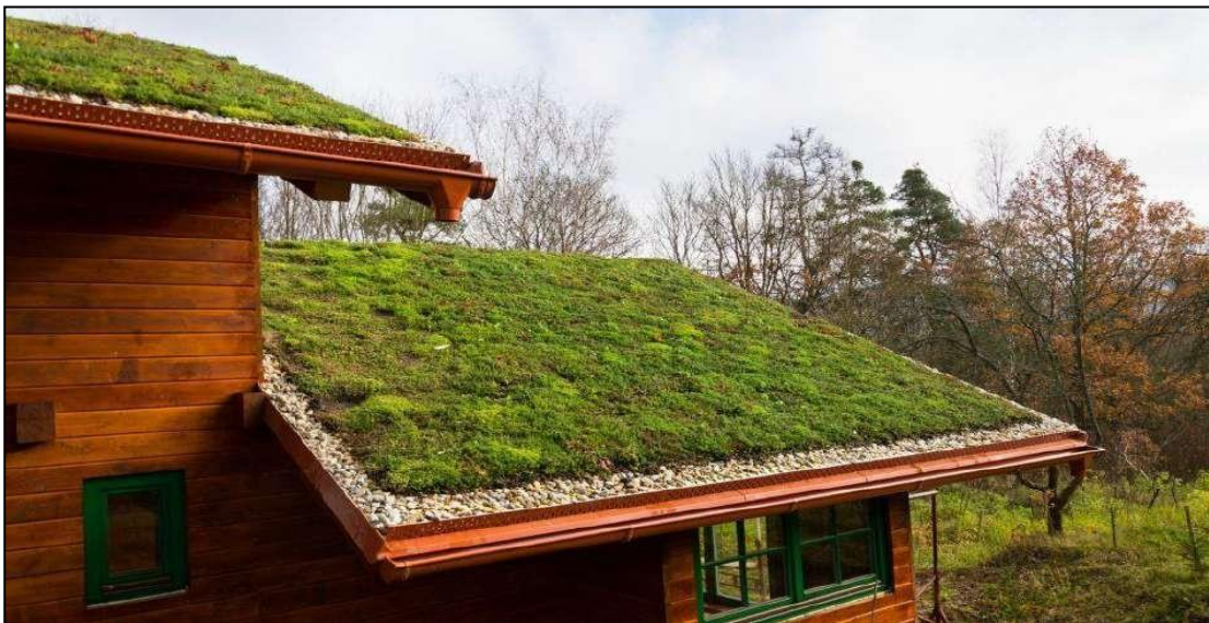
Figura 120 - Exemplo de aplicação de telhado verde em residência
